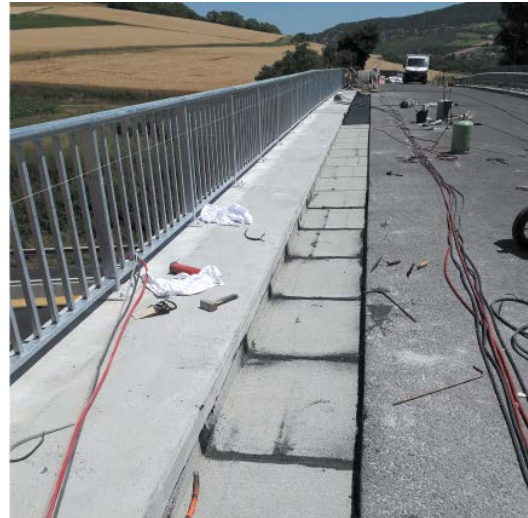
Reprise d'étanchéité par feuilles monocouches
