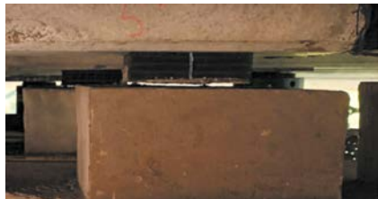
Vue sur les appareils d'appuis
