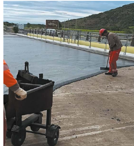
Réalisation de l'étanchéité et des enrobés sur tablier
