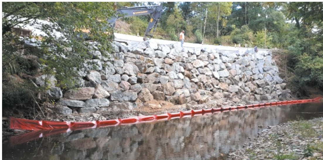
Enrochement avant retrait du barrage
