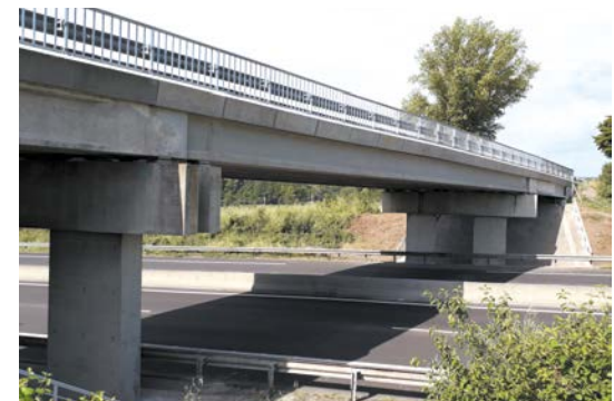
Enlèvement des graffitis sur piles, perrés et poutres de rive
