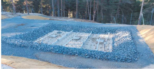
Aire Ouest Filtre planté de roseaux
