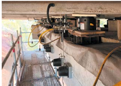
Vérinage du tablier (soulèvement de quelques millimètres du tablier)
