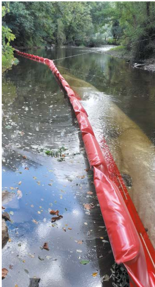
Barrage flottant/filtrant avec jupe lestée
