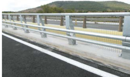
Mise en place des nouveaux dispositifs de retenue
