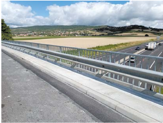
Reconstruction longrine-trottoir + bordures
