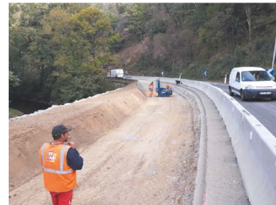
Essais charge sur plaque et pénétromètre avant travaux de structure et d'enrobé
