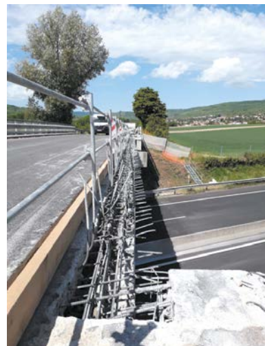
Aciers du hourdis après démolition
