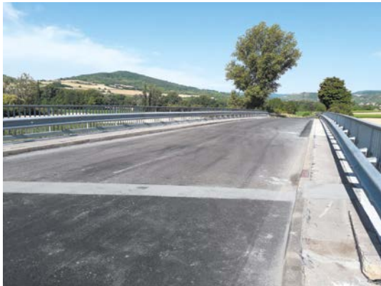
Reconstitution des joints à revêtement amélioré et enrobés aux extrémités de l'ouvrage
