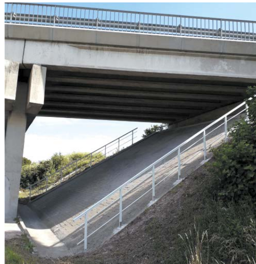
Garde-corps en matériau composite pour accès le long des perrés
