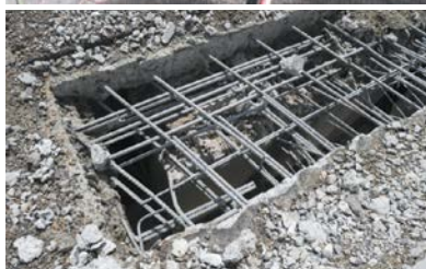
Mise à nu des aciers par hydrodémolition
