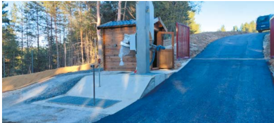
Aire Ouest Zone de prétraitement
