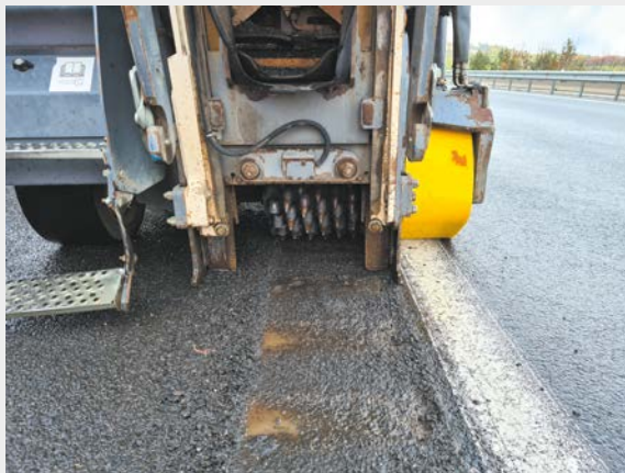
Réalisation des engravures par microrabotage en BAU
