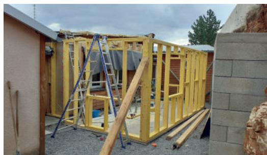
L'extension de la salle de réunion a nécessité au préalable le terrassement du terrain naturel et la construction d'un mur de soutènement. L'agrandissement du bâtiment a ensuite pu être réalisé avec une dalle béton supportant une ossature bois et une couverture en tôle bac acier. La réalisation du bureau des chefs d'équipe a, quant à elle, nécessité la démolition d'une cloison et la reprise du carrelage. Ces travaux ont été menés en site occupé.
