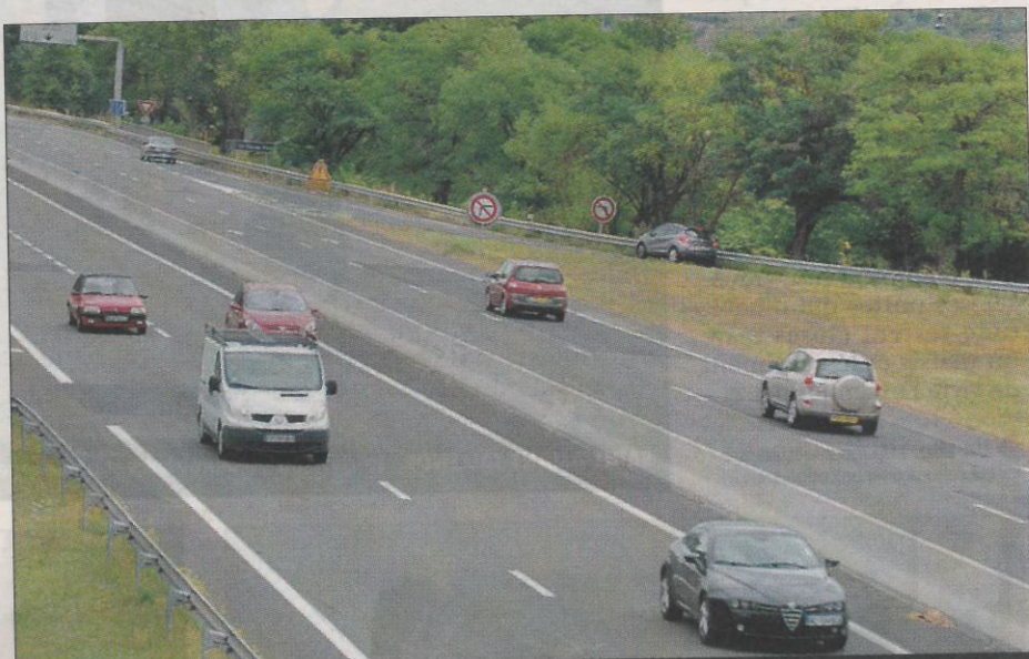
SENS SUD-NORD. Les deux voies seront rénovées dans le sens Béziers-Clermont. Elles seront fermées durant les travaux. La circulation s'effectuera sur les voies Clermont-Béziers.
