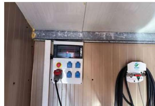
Mise en conformité électrique du local de l'aire de lavage par l'installation d'un coffret de protection étanche.
