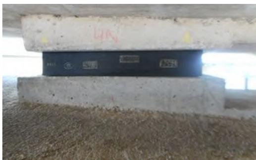
*Exemple de bossage neuf réalisé lors des phases précédentes*
