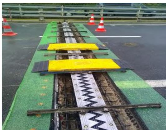
*Exemple de changement de joint de chaussée réalisé lors des phases précédentes*
