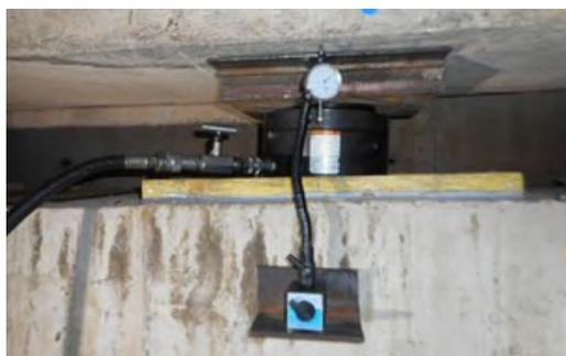
*Exemple de vérinage réalisé lors des phases précédentes*
