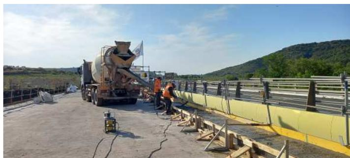
*Réalisation de la nouvelle longrine en béton sur laquelle seront fixés les dispositifs de retenue*
