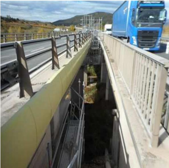
Pour libérer l'ouvrage en travaux de toute circulation de véhicules sur le tablier Est, le trafic qui y circule habituellement est basculé sur le tablier Ouest, pendant toute la durée du chantier.
