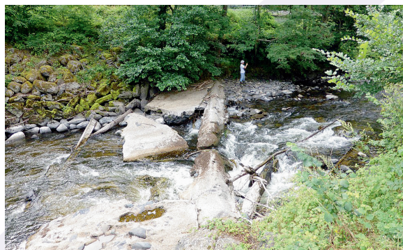
Vue générale avant travaux
