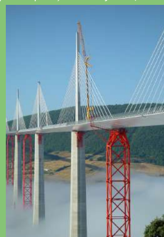
Viaduc de Millau en construction dans la brume (pile de pont). © JC Gayraud / Terra
