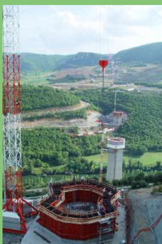
Construction des piles du Viaduc de Millau. © JC Gayraud / Terra
