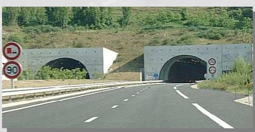
A75 - Tunnel de Montjézieux
