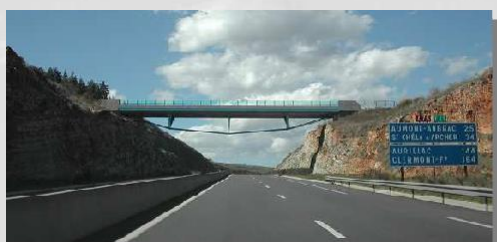
A75 - PR 160+303 : Arc sous-bandé du truc de la Fare
