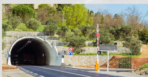
RN102 - Aubenas : Tunnel du Baza
