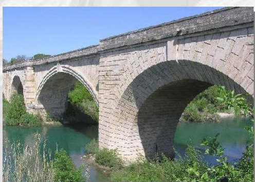
RN109 - Pont de Gignac sur l'Hérault
