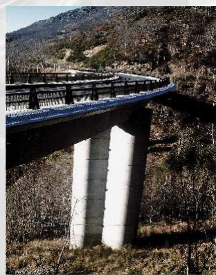
RN106 - PR 29+400 : Viaduc de Poumas
