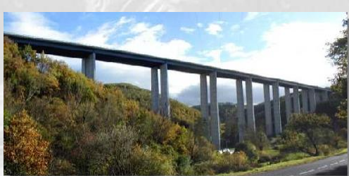
A75 - PR 62+880 : Viaduc de la Violette
