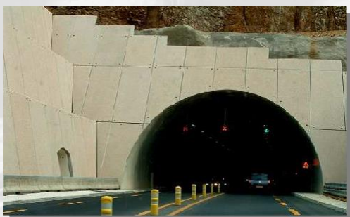
A75 - Tunnel du Rocher de la Vierge
