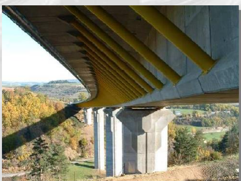
A75 - PR 158+927 : Viaduc du Rioulong
