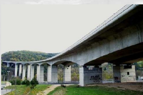
RN88 - PR 5+616 : Viaduc de Pont-Salomon
