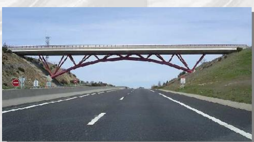
A75 - Échangeur d'Antrenas : Arc treillis métallique
