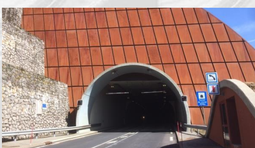
RN122 - Nouveau tunnel du Lioran
