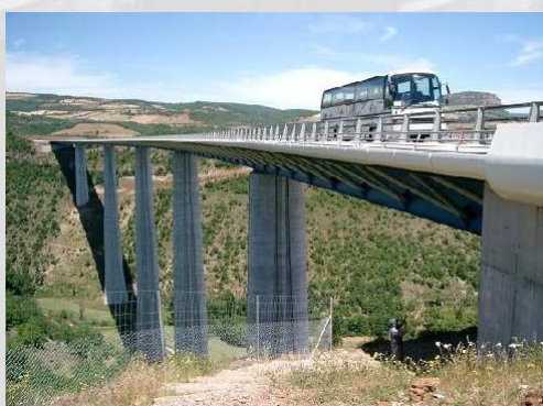
A75 - PR 207+000 : Viaduc de Verrières
