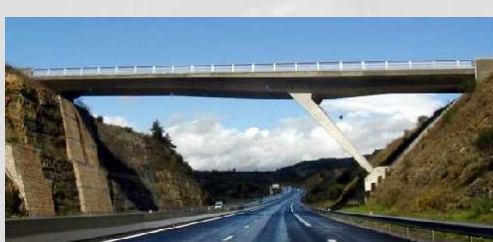
A75 - PR 168+851 : Pont mono-béquille de la RD52
