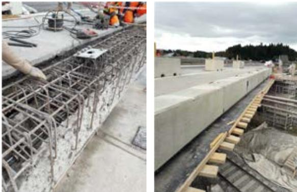
Ferrailage longrine et engraissement du tablier
