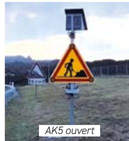
L'entreprise « SIGNATURE », qui a été sélectionnée, a procédé à l'installation, suivant le plan établi par le CEI, de l'ensemble des séquences de fermeture de voie du tunnel du Pas de l'Escalette depuis la mise en place des massifs jusqu'à la pose des panneaux : B3A (Interdiction de dépasser pour les PL) ; AK5 (attention zone de travaux) ; KD10 (réduction des voies de circulation).
