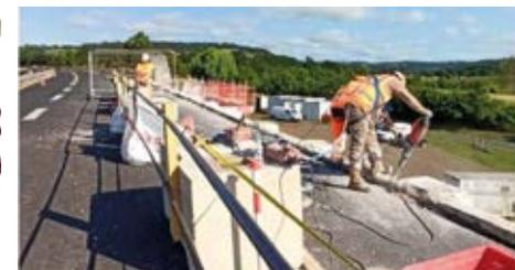
Platelage pour travaux au-dessus de la voie ferrée > Maintien du gabarit SNCF
