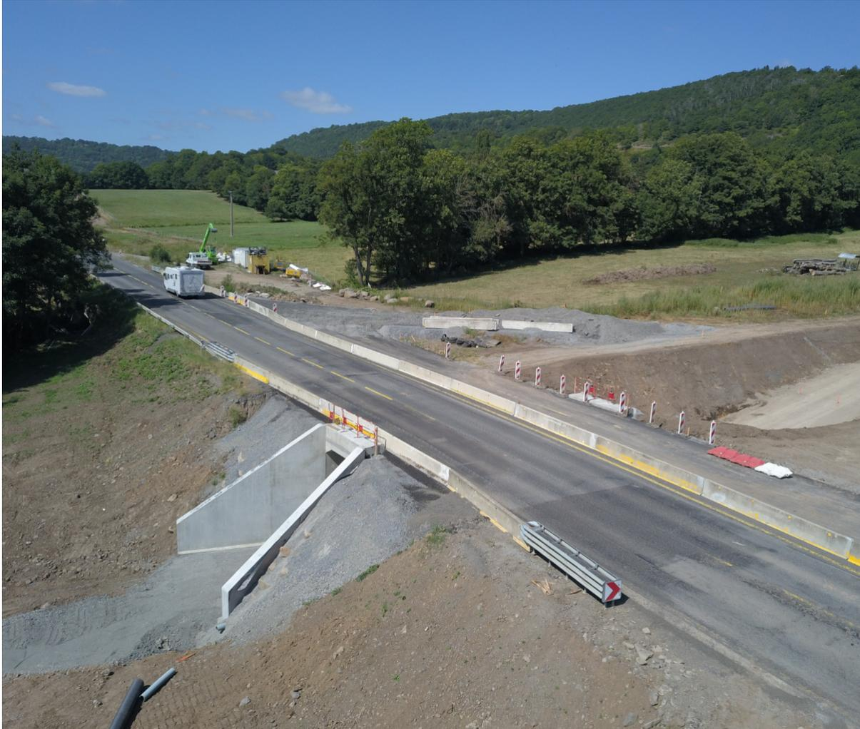
*Illustration ci-dessus : le Boviduc, en phase travaux, permet aux engins agricoles et aux troupeaux de traverser la RN 122, en garantissant la sécurité des usagers et des exploitants agricoles.*
